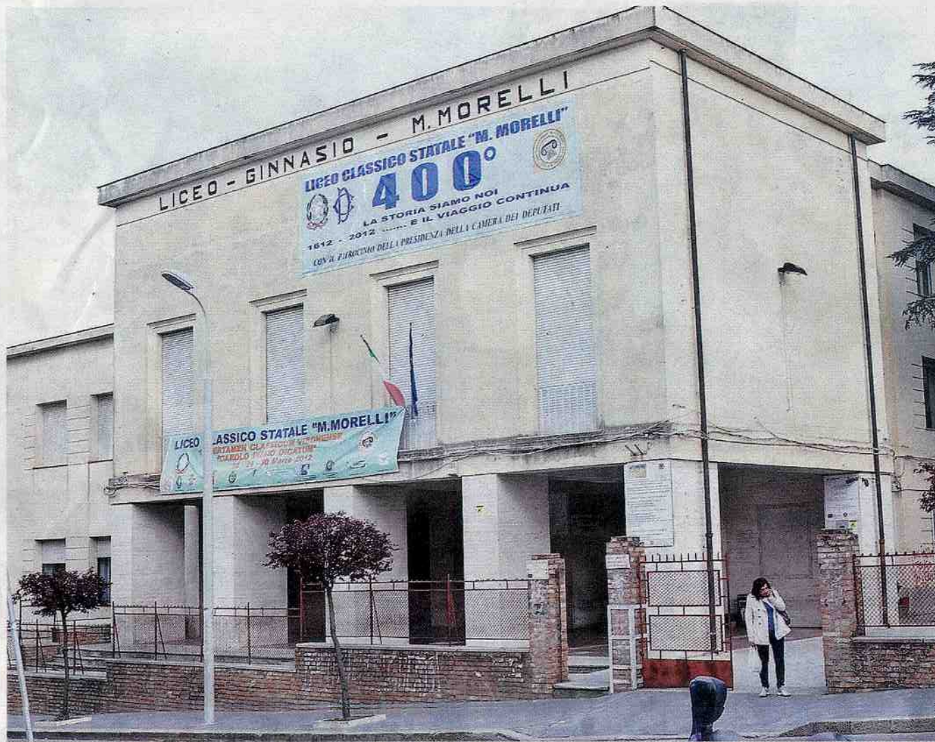
Il Liceo classico "M. Morelli" comincia a mostrare dal punto di vista strutturale tutto il peso dei suoi anni
