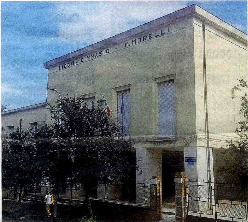
L'immobile. Pareti umide, ascensore mai realizzato, impianti vetusti, bagno per disabili inesistente
