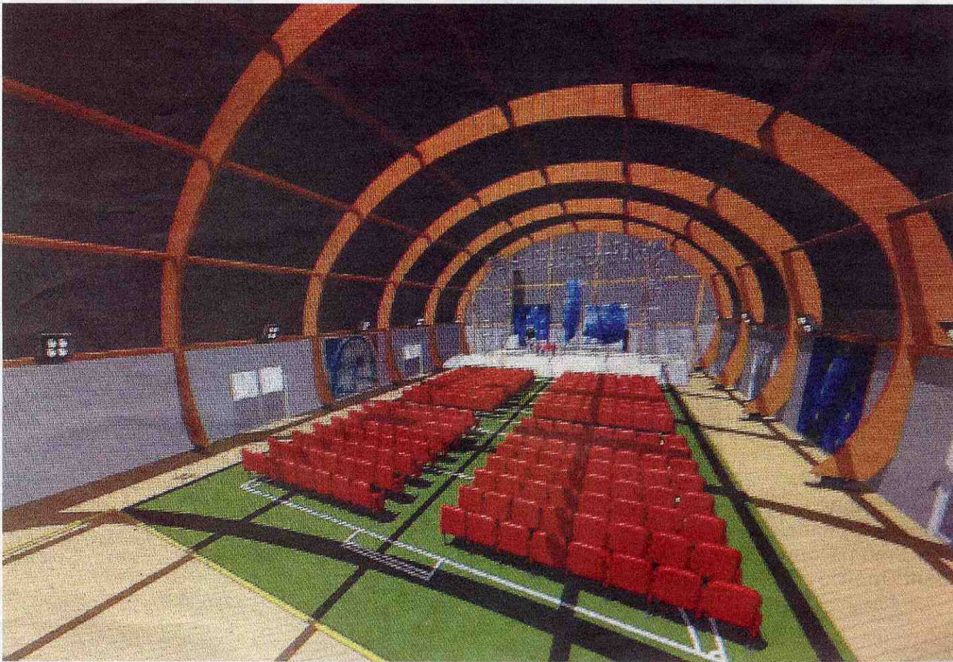
Il progetto. La moderna palestra sarà realizzata interamente in legno lamellare di abete
